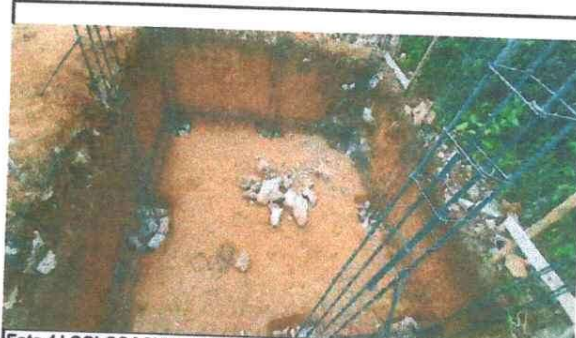
Foto 4: COLOCACION DE LAS COLUMNAS DEL TANQUE DE CAPTACION DE AGUA LLOVEDIZA. 08/05/2024
