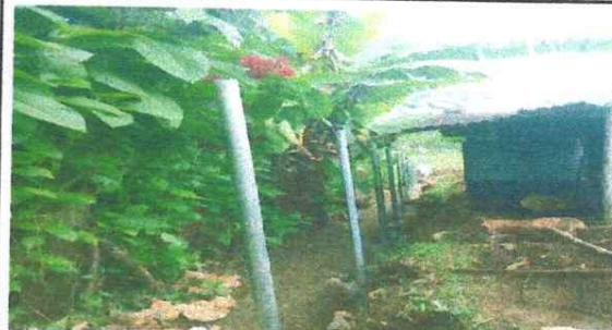
Foto 2: TUBOS GALVANIZADOS DONDE SE COLOCARÁ LA MALLA PERIMETRAL. 08/08/2024.
