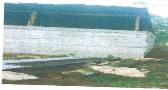
Foto 6: FUNDICION DE LA CORONA DEL TANQUE DE CAPTACION DE AGUA LLOVEDIZA. 17/05/2024
