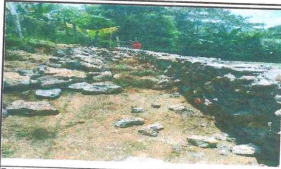
Foto 2: CONSTRUCCION A MITAD DE LA EJECUCION DEL MURO DE CONTENSION. 30/04/2024
