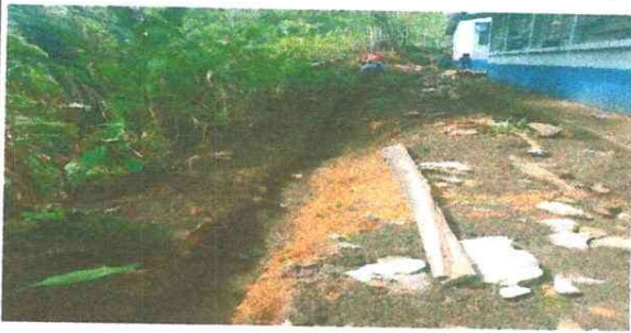
Foto 1: ZANJEADO DONDE SE COLOCARÁ LA MALLA PERIMETRAL DEL PREDIO ESCOLAR. 15/05/2024
