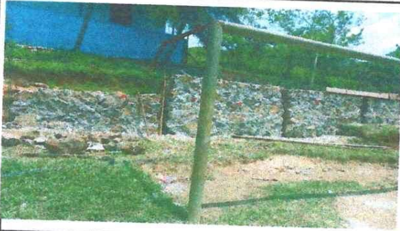
Foto 3: VISTA FRONTAL DEL MURO DE CONTENSION A 80% DE SU EJECUCION. 13/05/2024
