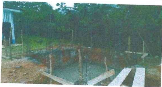
Foto 5: FUNDICION INICIAL DEL TANQUE DE AGUA. 13/05/2024
