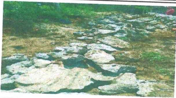
Foto 1: ZANJEADO Y COLOCACION DE PIEDRAS DEL MURO DE CONTENSION. 22/04/2024
